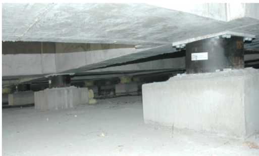
Fig. 1. Colocación de aisladores sísmicos
